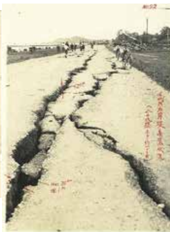
鳥取震災 千代川右岸亀裂状況 (鳥取県立公文書館提供)
