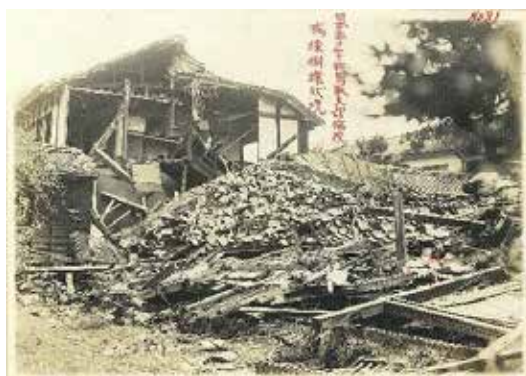
鳥取震災 日赤病院病棟倒壊状況 (鳥取県立公文書館提供)
